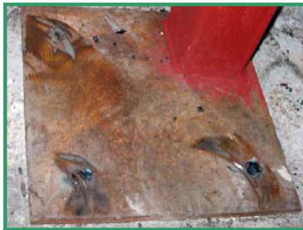
شکل ۱۱: سطح فوقانی صفحه ستون پس از اتمام کار
