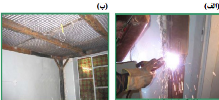
شکل ۸: (الف) جوش قسمت میانی ستون، (ب) طرح نهایی سازه پس از آزاد شدن جک‌ها
