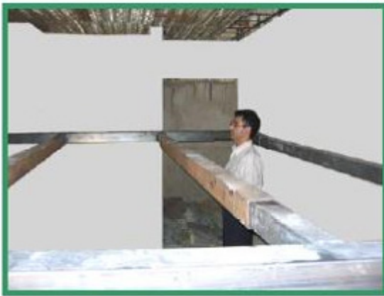
شکل ۵: (الف) جاگذاری تیرها بین ستون‌ها، (ب) جاگذاری تیرهای میانی در محل خود.
