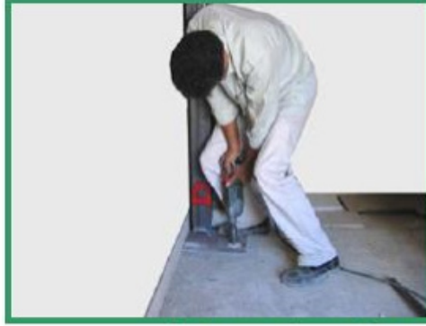
شکل ۹: سوراخ کردن موزائیک کف و پیچ کردن صفحه ستون‌ها به آن
