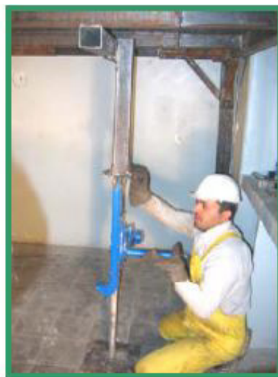
شکل ۷: بالا بردن سقف سازه به وسیله جک
