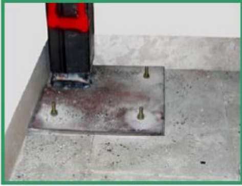
شکل ۹: سوراخ کردن موزائیک کف و پیچ کردن صفحه ستون‌ها به آن
