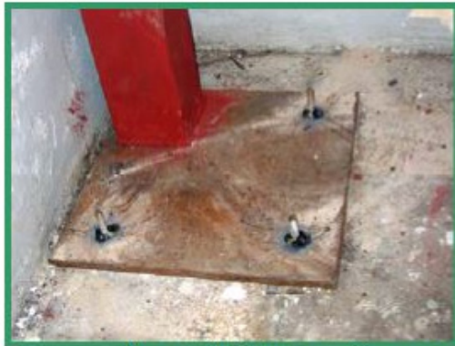
شکل ۱۰: الف) جوش دادن پیچ‌ها به صفحه ستون و ب) سنگ زدن سطح فوقانی پیچ‌ها
