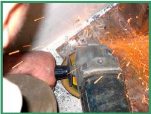
شکل ۱۰: الف) جوش دادن پیچ‌ها به صفحه ستون و ب) سنگ زدن سطح فوقانی پیچ‌ها
